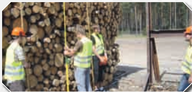
Apaļo kokmateriālu uzmērīšana krautuvēs
