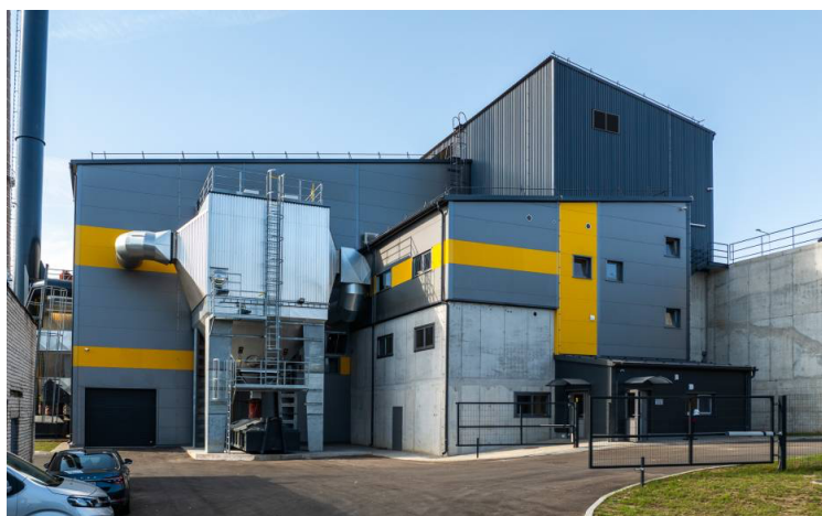
2.2.1.2.2. attēls. „Daugavpils siltumtīklu” jaunā katlumāja Silikātu ielā 8 Daugavpilī
