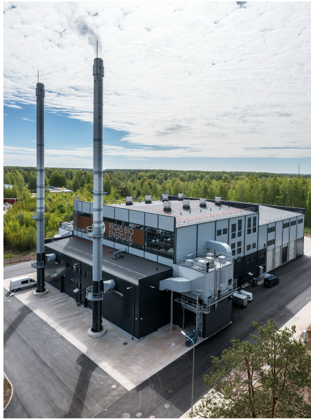
2.2.1.2.1. attēls. „Rīgas bioenerģijas” jaunā katlumāja Rencēnu ielā 30 Rīgā
