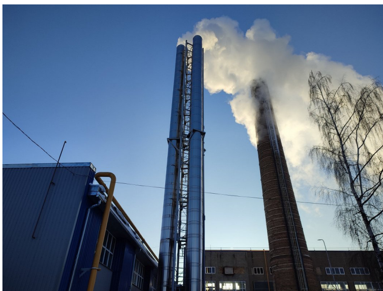
2.2.1.2.3. attēls. „Rēzeknes siltumtīklu” jaunā katlumāja N. Rancāna ielā 5 Rēzeknē
