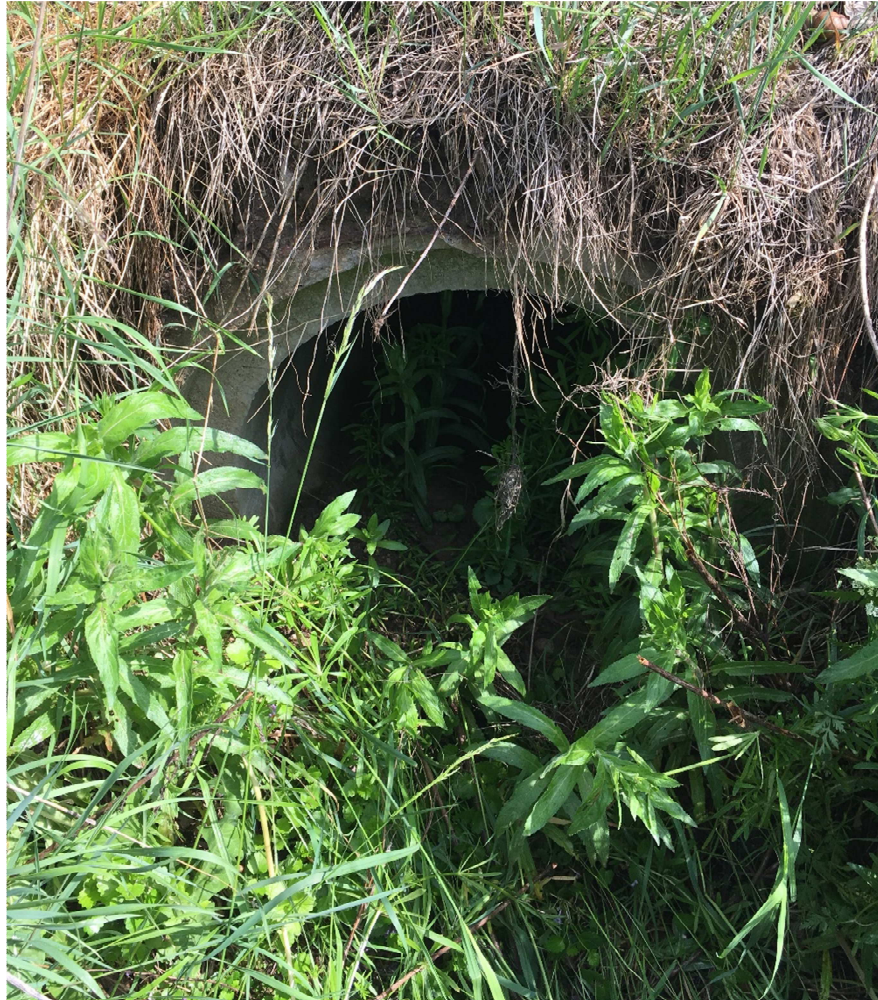
42. att. Bērzes 1.vietas grāvja sākuma caurteka.
