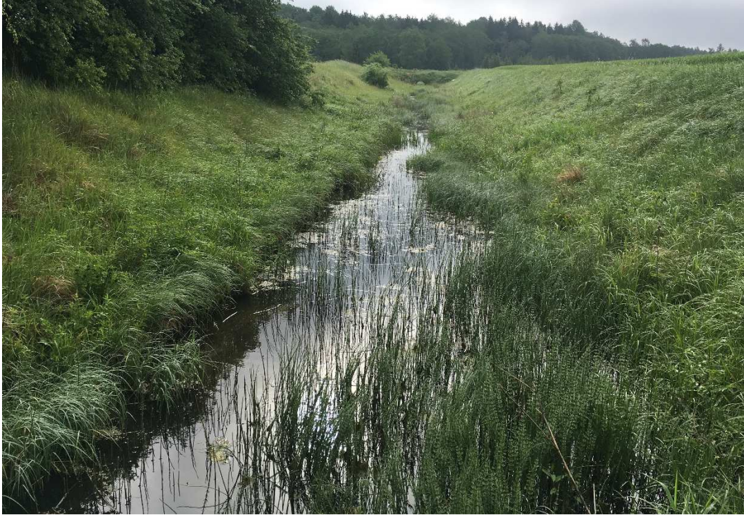
8. att. Skats no pārgāznes uz grāvja turpinājumu Mellupītes 1. vietā.
