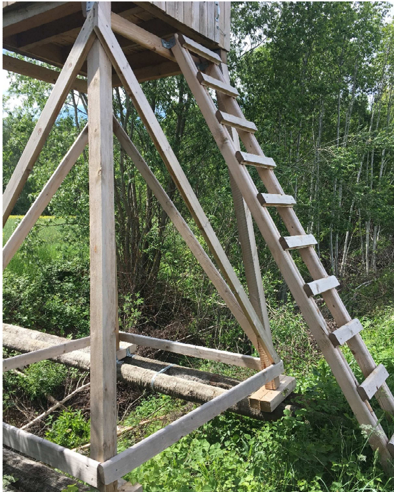
29. att. Mednieku tornis pār Ailes straucha 1. vietas grāvi.
