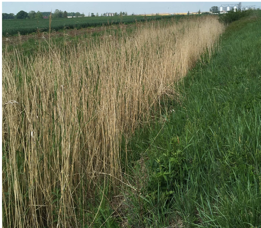
51. att. Skats uz Bērzes 2. vietas grāvi no grāvja pārtīrītās daļas uz nepārtīrīto daļu.
