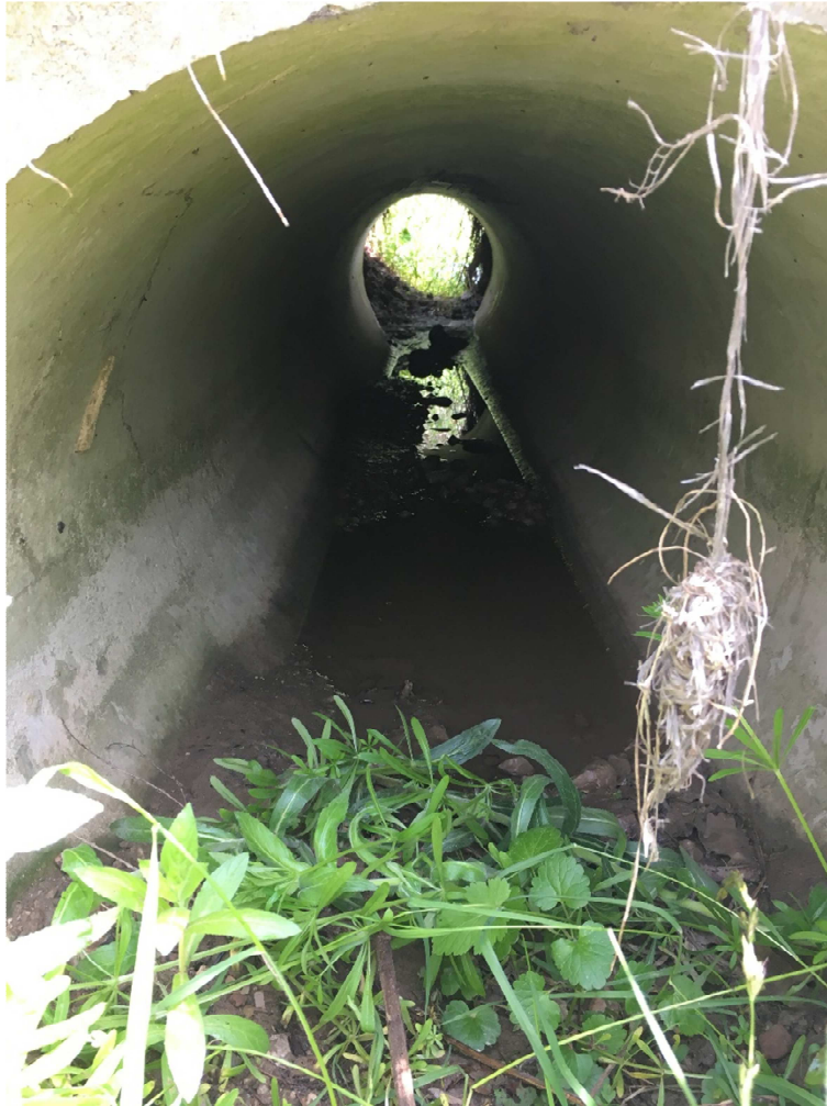
43.att. skats caur Bērzes 1.vietas grāvja sākuma caurteku.
