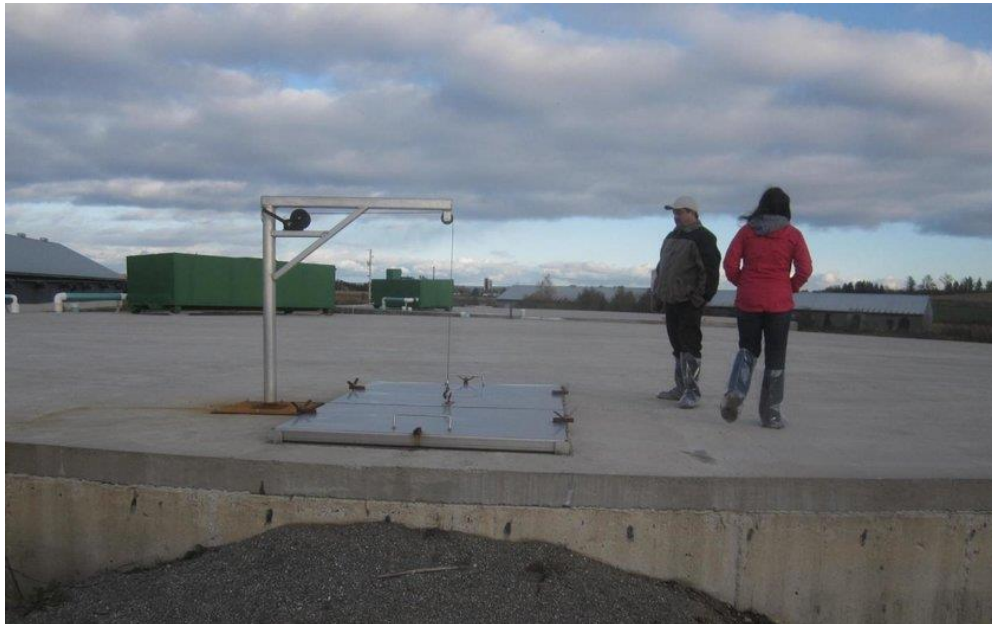
13. attēls. Šķidrmēslu krātuve ar betona pārsegumu
