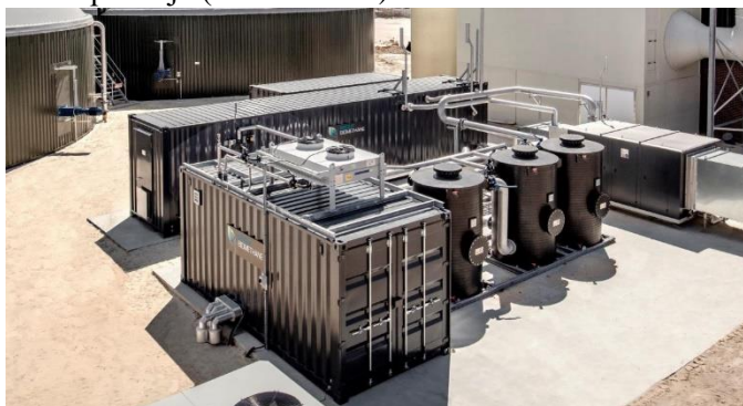
att. 4.2. Membrānu separācijas sistēma 38 .
