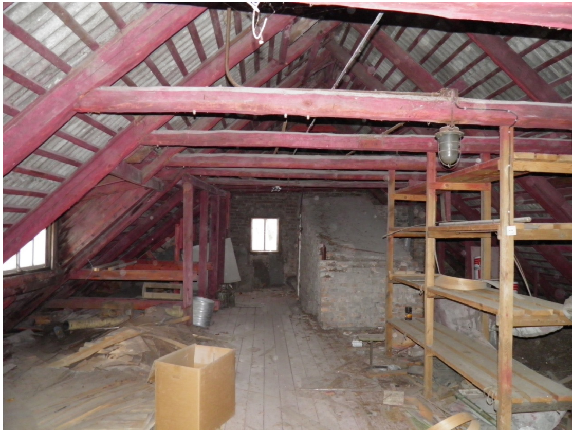
11. Bēniņu apaļkoku jumta konstrukcija ēkas ZR galā.
