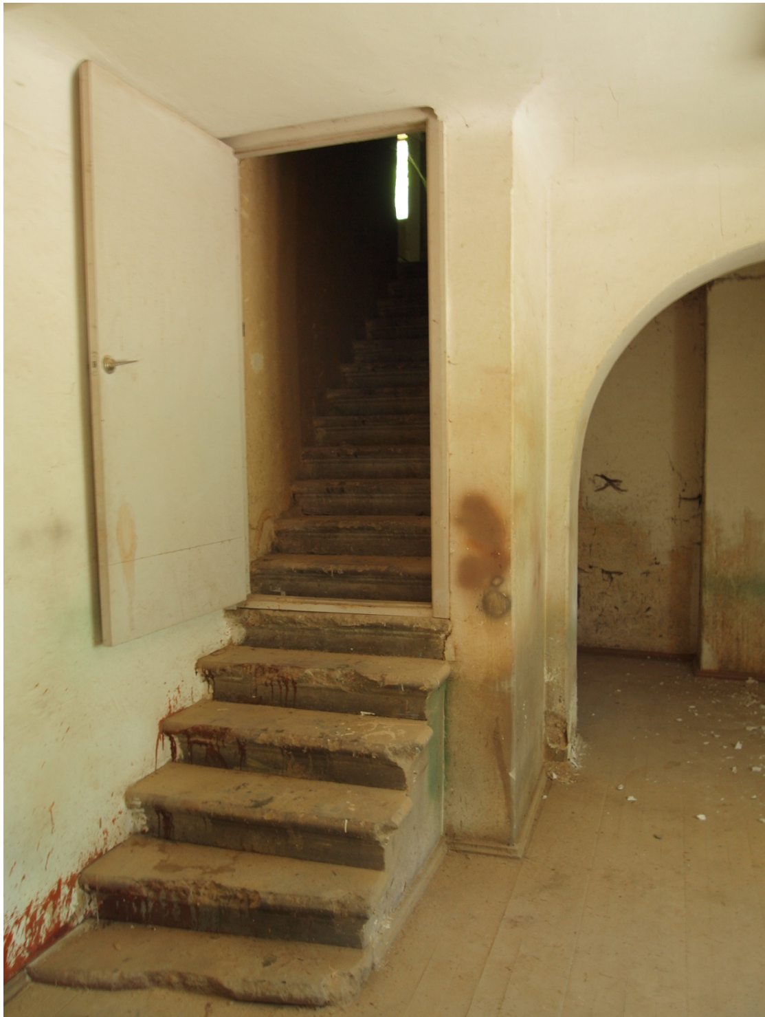
16. Grīdas konstrukcijā iedzīljinātas betona kāpnes uz bēniņiem. Ēkas ZR galā
