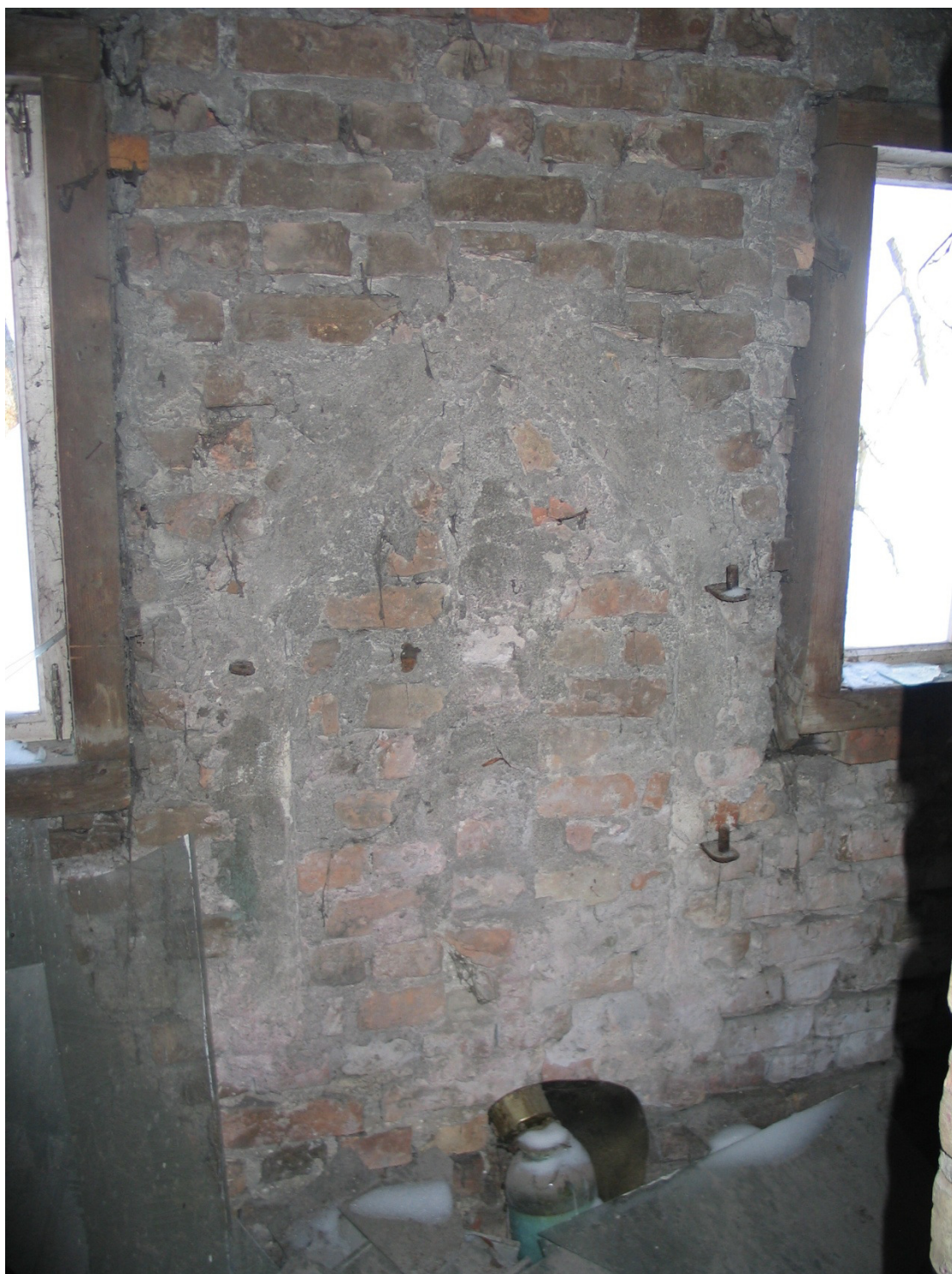
12. Aizmūrēta smailloka aila ēkas ZR zelminī.
