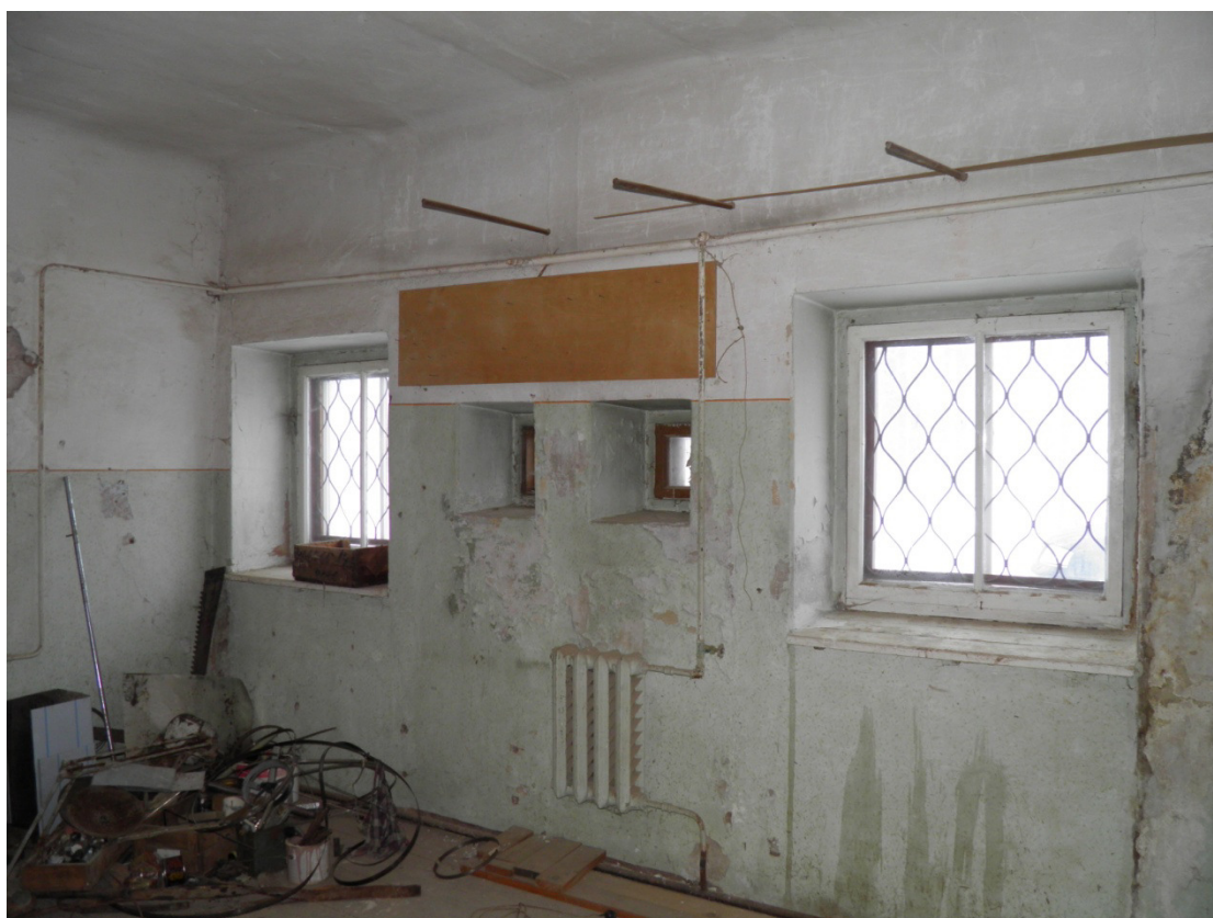
18. Aizmūrētas durvju aillas uz tualetēm skatā no telpas. Redzamas starpsienu pēdas griestos.
