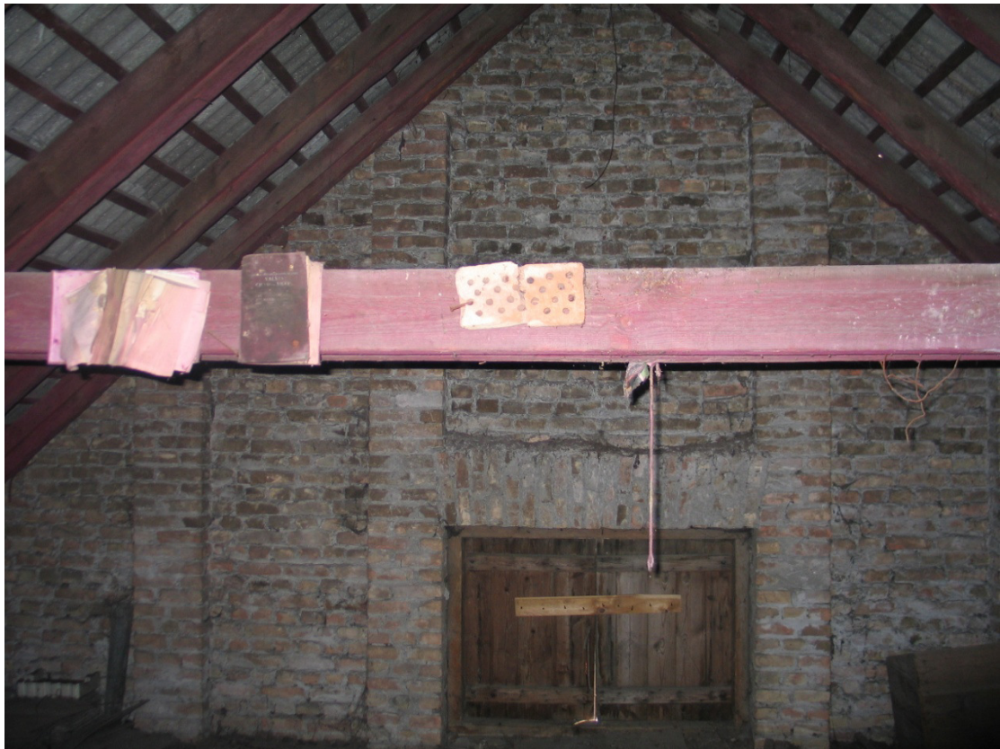
13. Ēkas DA zelminis ar bēniņu lūku un apzāģētu kokmateriālu jumta konstrukciju.
