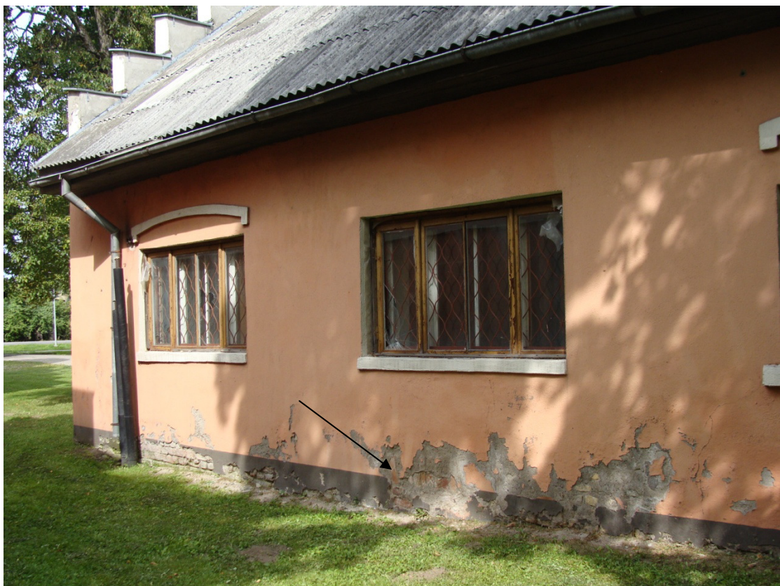
10. DR fasādes fragments ar aizmūrētas ailas augšdaļu cokola daļā un 2 atšķirīga augstuma logailām.
