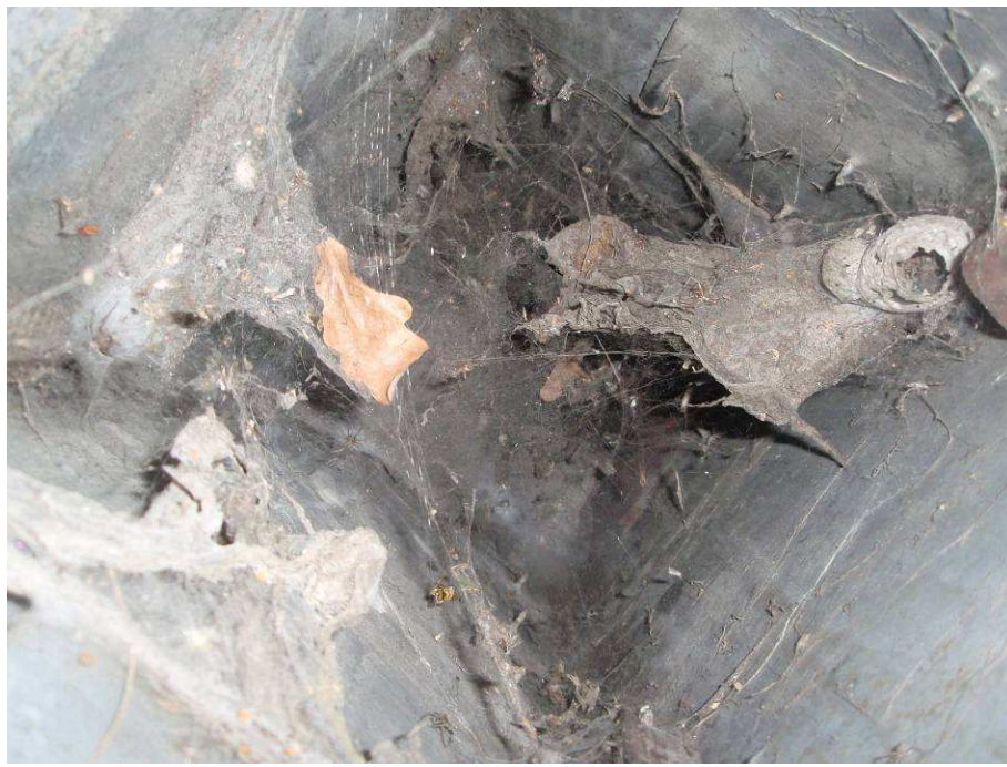
28. att. Aizsērējusi ventilācijas sistēma
