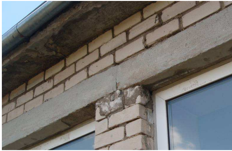
8. att. Logu pārsedžu balstījums
