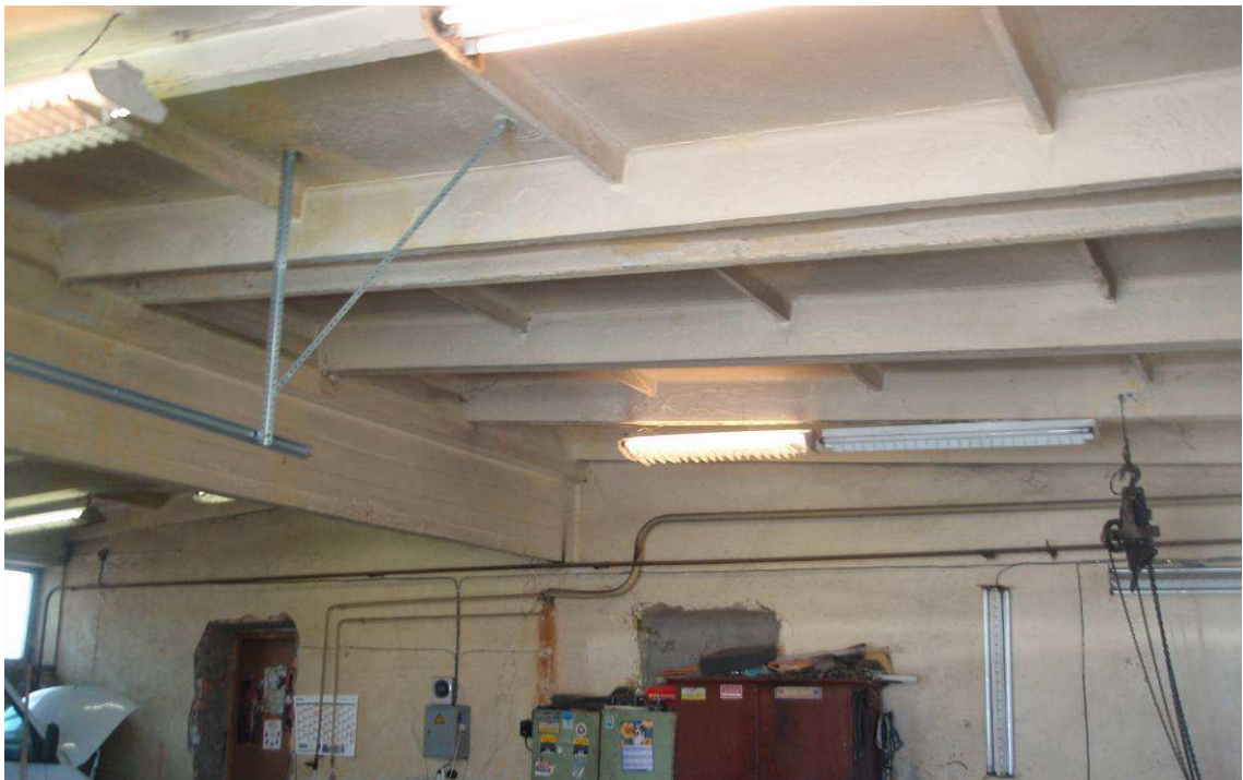
Foto attēls Nr. 7 Jumta nesošā pārseguma konstrukcija
