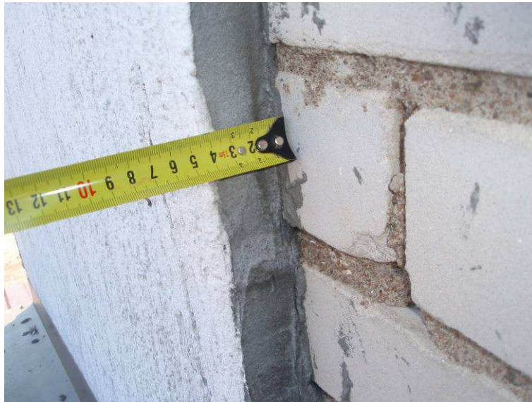
6.att. Fasādes siltinātās daļas siltumizolācija
