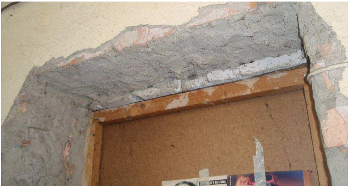
Foto attēls Nr. 10 Durvju ailes pārsegums
