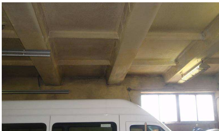
Foto attēls Nr. 9 Jumta pārseguma paneļu balstījums uz sienas nesošās konstrukcijas
