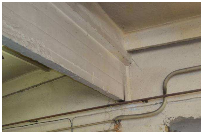
12. att. Galvenā nesošā dz/betona sija pārseguma paneļu balstīšanai
