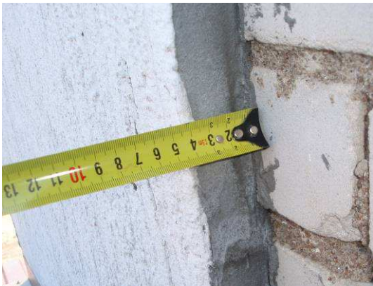
Foto attēls Nr. 14 Siltinātājuma biezums
