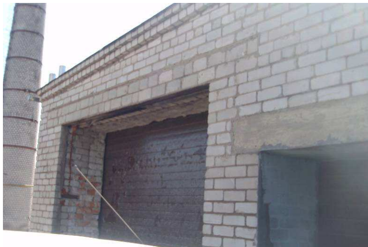
7.att. Pārsedzes garāžas vārtiem
