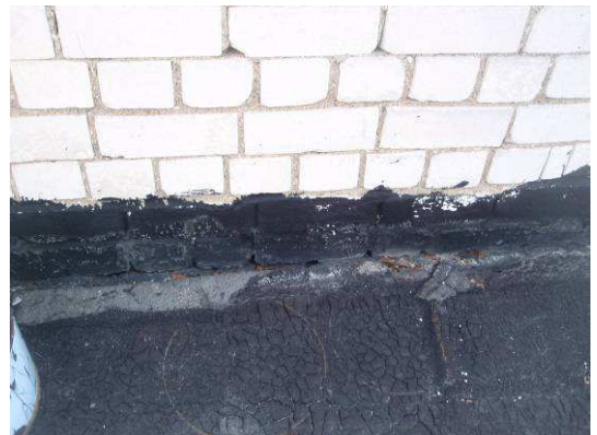
Foto attēls Nr. 27 Jumta seguma pieslēgums sienai
