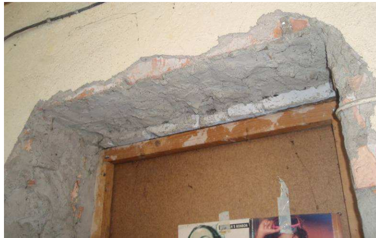
9. att. Durvju aile bez pārseguma
