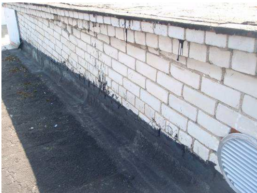
Foto attēls Nr. 26 Jumta seguma pieslēgums sienai
