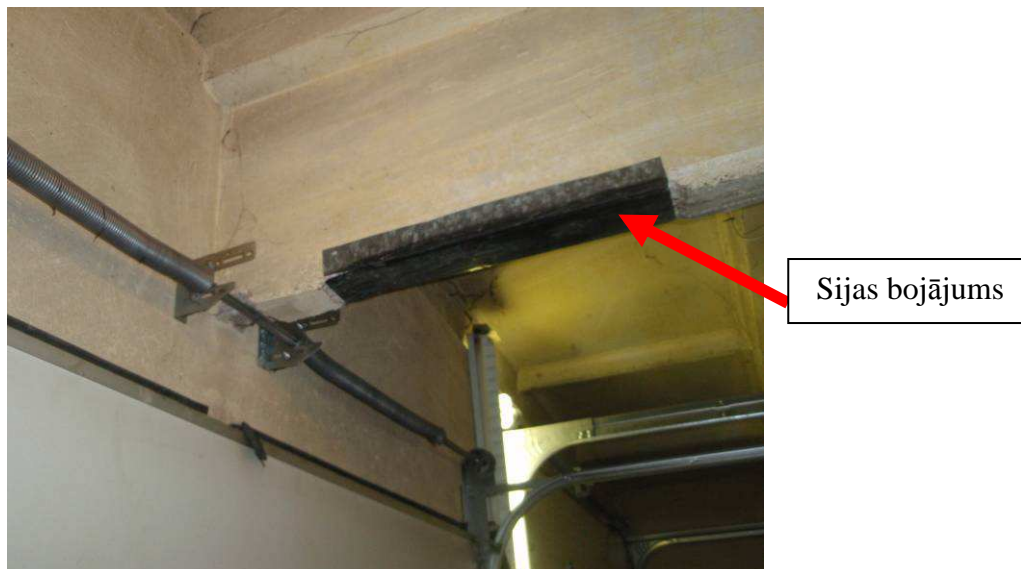
13. att. Galvenās nesošās dz/betona sijas bojājums
