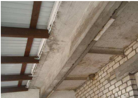
Foto attēls Nr. 38 Jumtiņa pieslēgums pie pārseguma plātnēm
