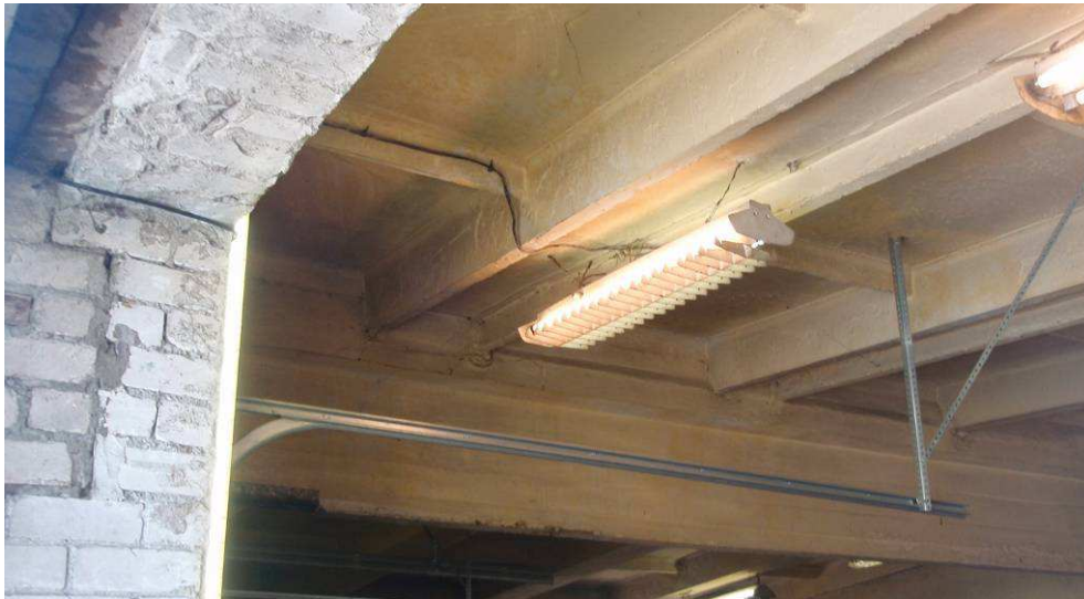
Foto attēls Nr. 13 Garāžas paceļamo vārtu konstrukcijas stiprinājums pie pārseguma paneliem
