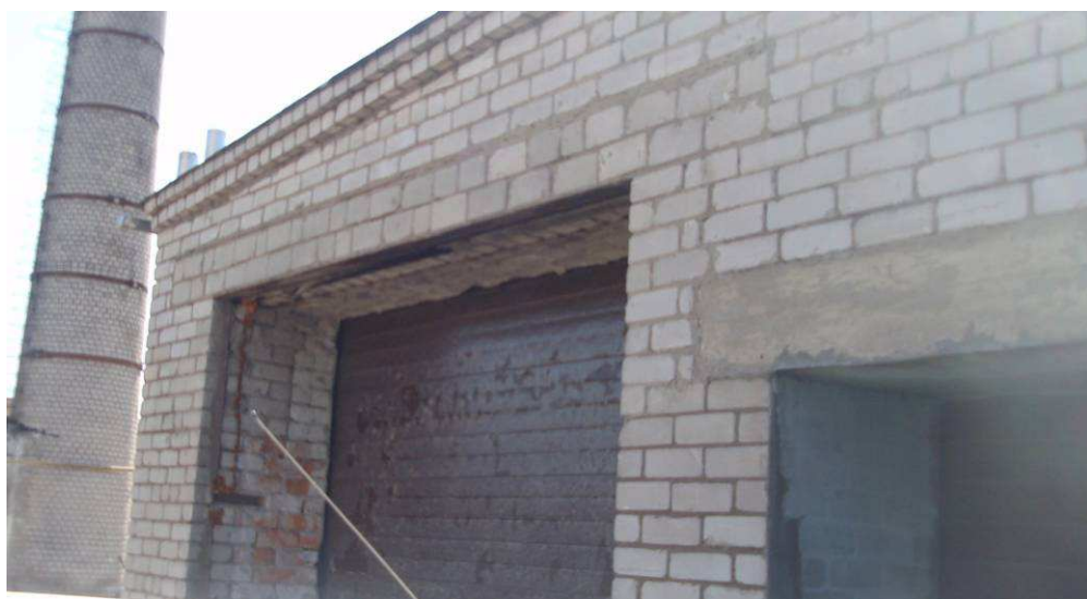
Foto attēls Nr. 12 Garāžas vārtu pārsedzes sijas
