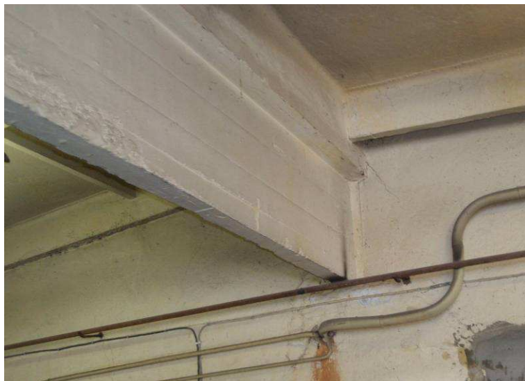
Foto attēls Nr. 8 Jumta galvenā nesošā sija
