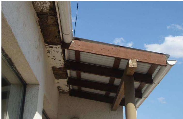
11. att. Jumtiņu pārseguma konstrukcija
