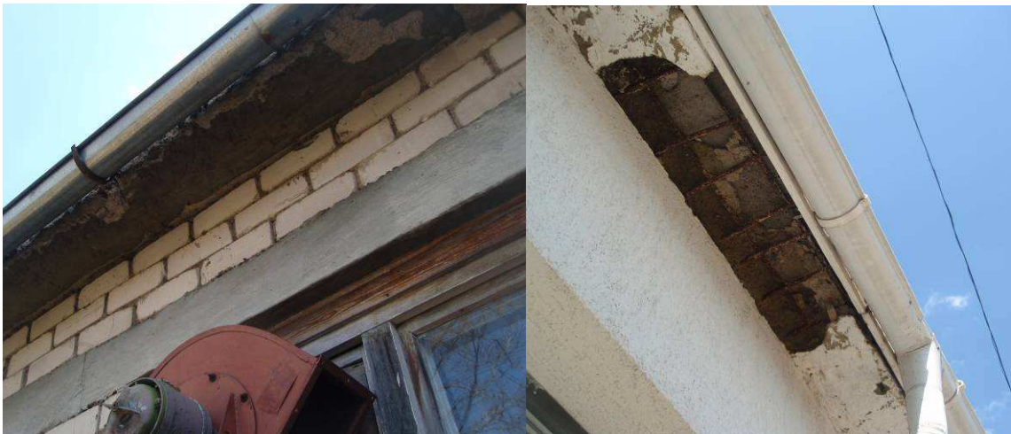
19. att. Dzegas betona konstrukciju bojājumi
